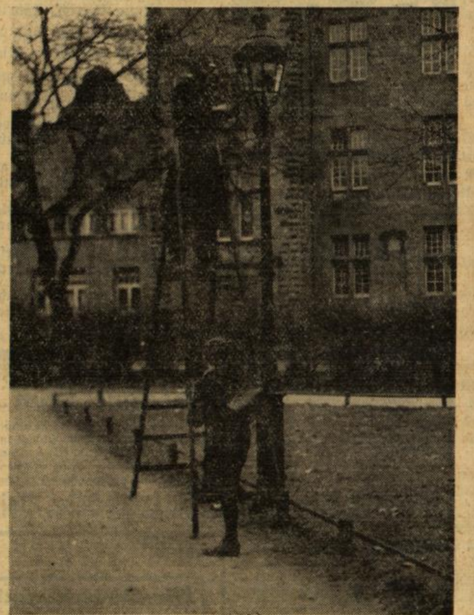
Laternenputzer bei der Schillerschule
