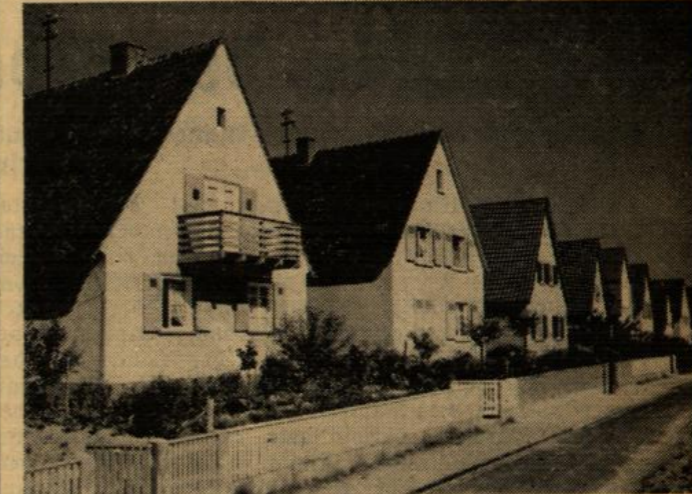
Eigenheim-siedlung Weingärten. Einheitlicher Gesamteindruck durch Bauvorschriften (Baukörper und Vorgarteneinrichtungen). Freiheit in der Einzelausbildung. Aufnahme: Stadtplanungsamt/Förster
