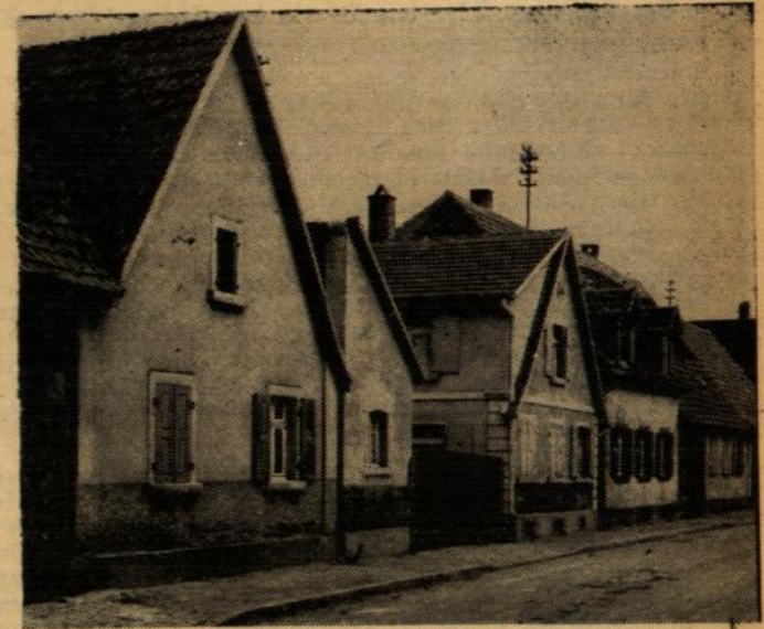
Eine Vorort-Dorfstraße. Veranlaßt durch willkürliches Bauen Aufnahme: Stadtplanungsamt/Scheffel
