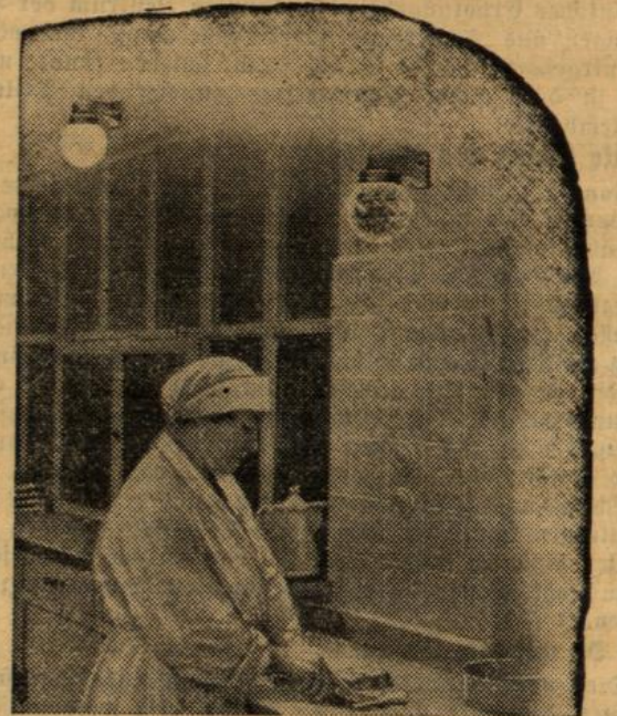
Saubere Kantinebeleuchtung. Ueber Arbeitstisch und Warenausgabe sind Wandleuchten mit Opalglaskugeln angebracht, die das Licht der Glühlampen blendungsfrei abschirmen.
