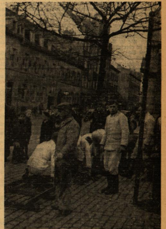
Der Reichsarbeitsdienst beim Schienenbau hinter der Hauptpost
