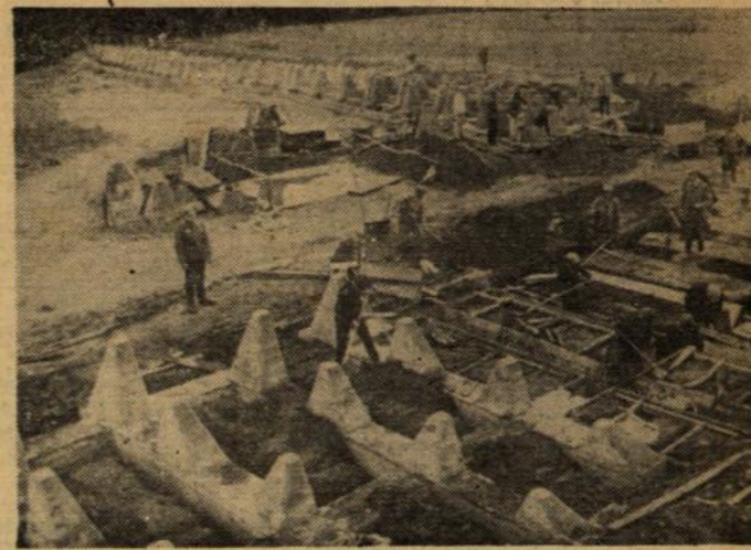
Höckerhindernis im Bau
