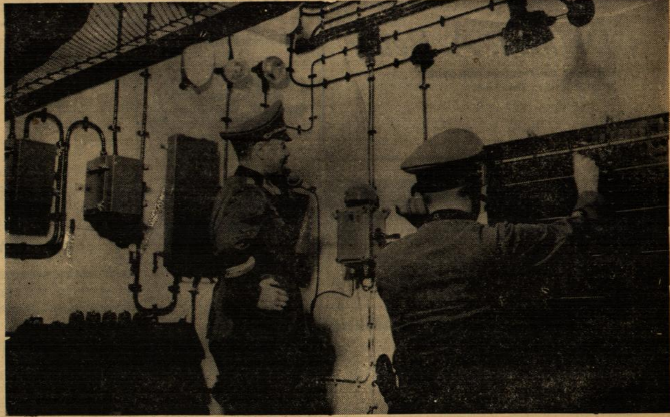
Blick in die Nachrichtenzentrale eines Panzerwerkes
