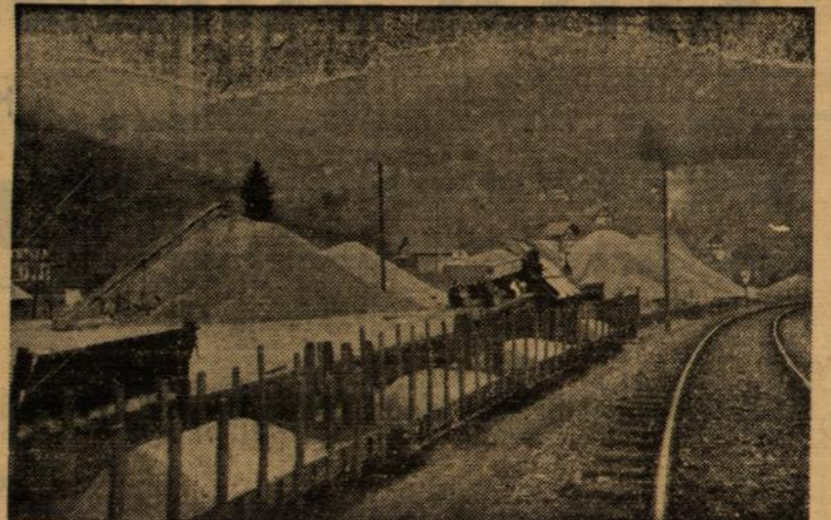
Edelsplittlager mit Verladegeleis
