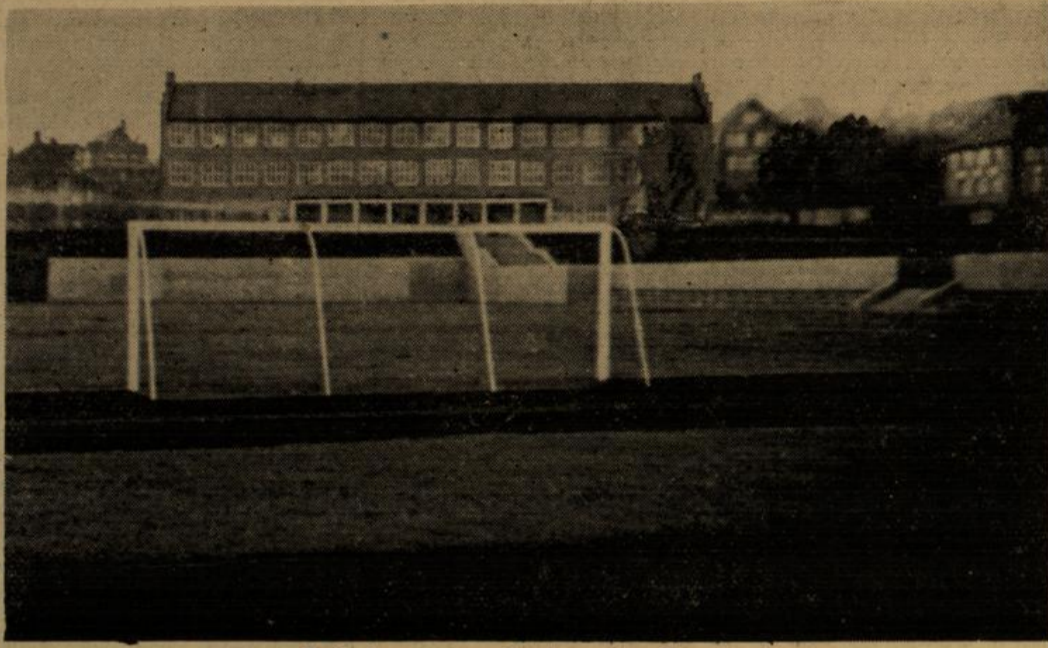
Teil des neuen Stadions in Gernsbach
