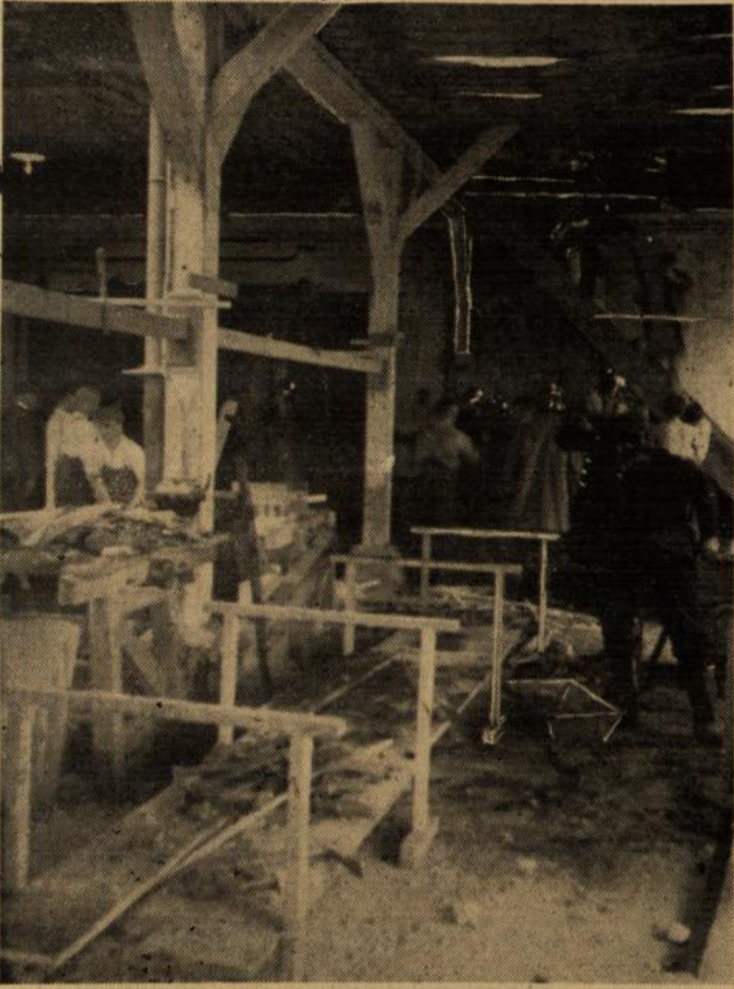
Aufräumungsarbeiten am Brandplatz (Aufn.: Richardt)
