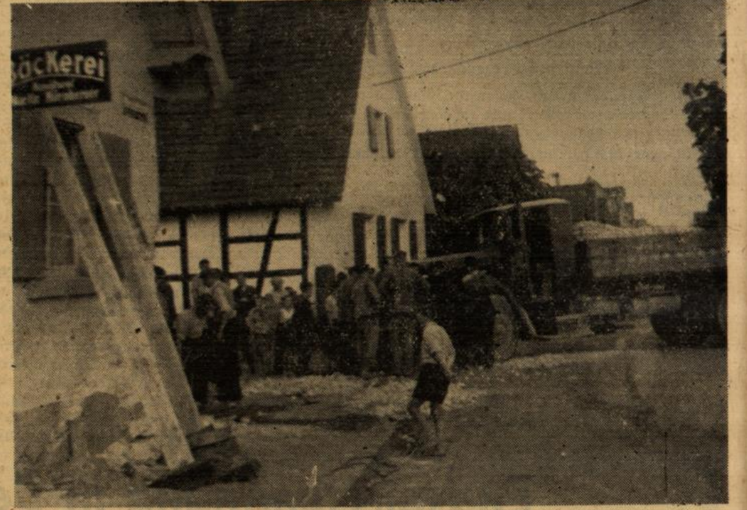
Das demolierte Wohnhaus. Im Hintergrund wird der verunglückte Lastzug abgekippt
