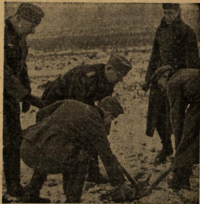
Aufräumungsarbeiten im Vorfeld
