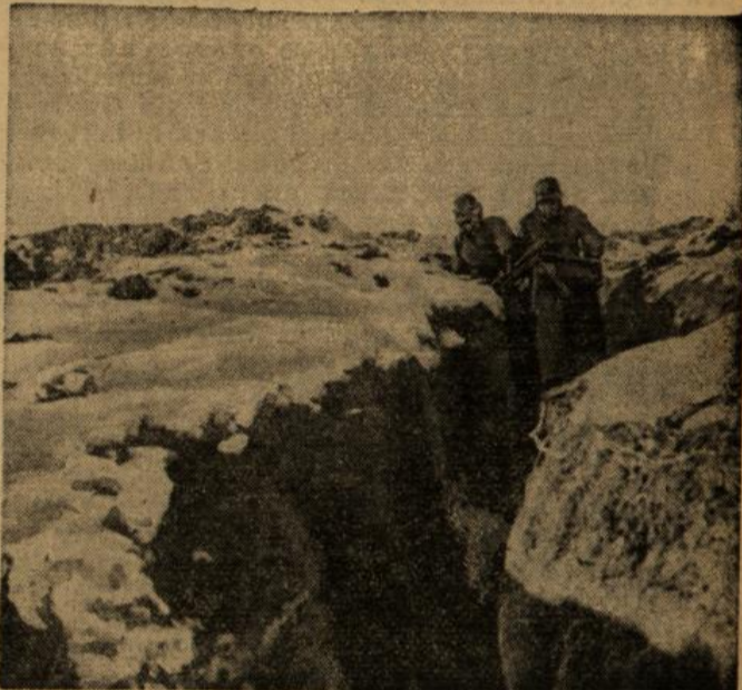
Im Laufgraben nach vorn.
