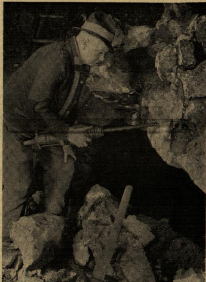
Die Bohrmaschine und ihr Pleinluft-Antrieb, mit geborgtem Geld gekauft, sind heute abgebaut. Das Bohrloch für die Sprengpatrone liegt im Deckstein einer großen Höhle. Das bei der Sprengung losgerüttelte Erz wird mit Donnerkrachen in fünfzehn Meter Tiefe fallen.
