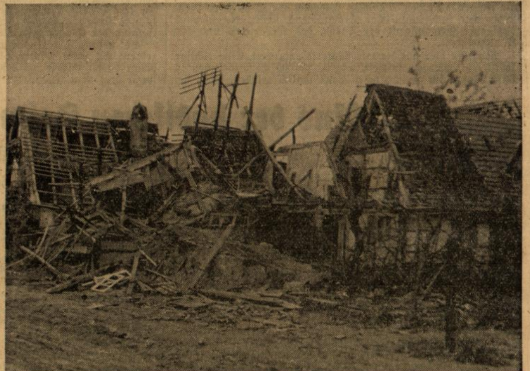
Schutthaufen, ragende Kamine und Ruinen säumen die Straßen Lauterburgs
