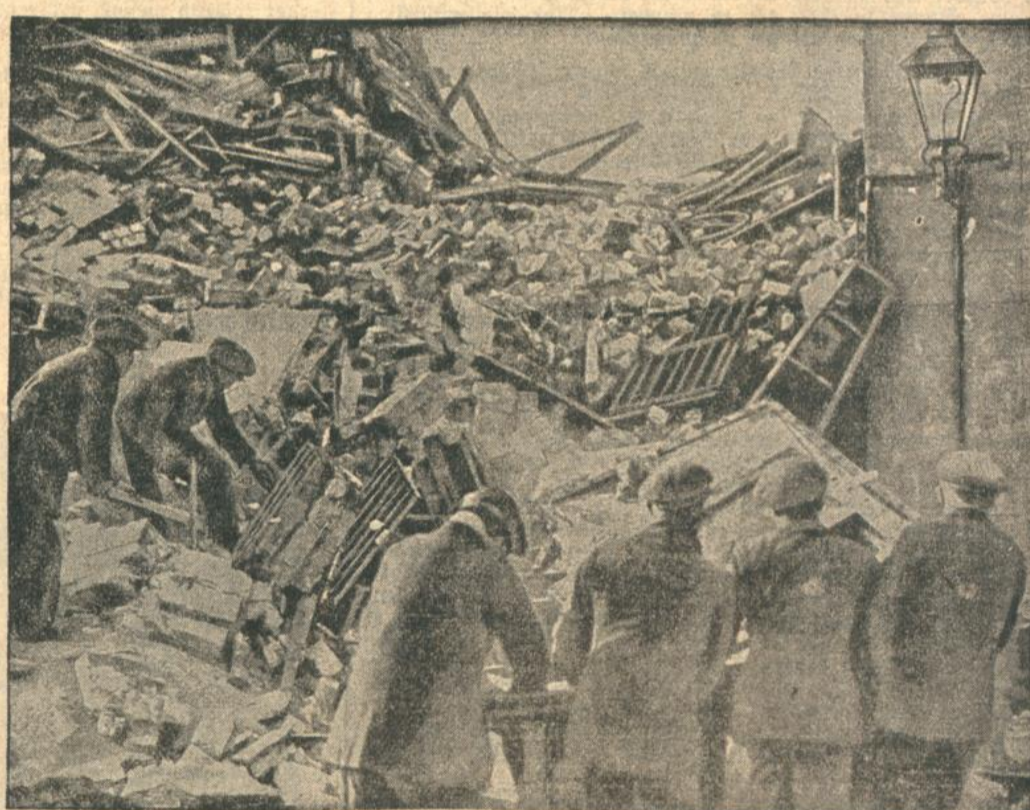
Hauseinsturz in Hull.
