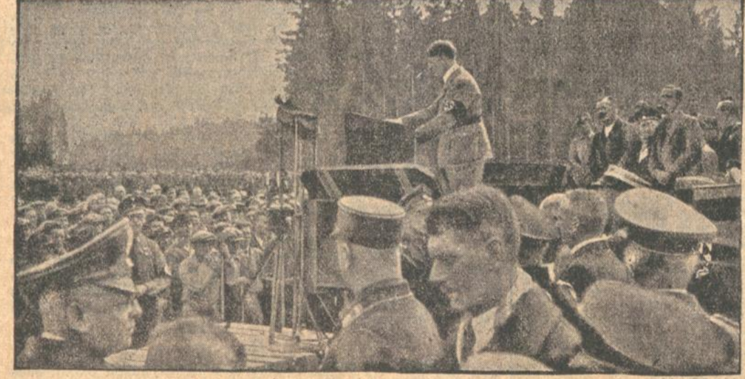
Der Reichskanzler bei seiner Rede auf der Baustelle Unterhaching der Reichsautobahn München-Landesgrenze, im Vordergrund links Reichsarbeitsminister Seldt.
