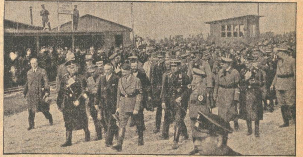
Die Besichtigung der Baustelle durch den Führer.
