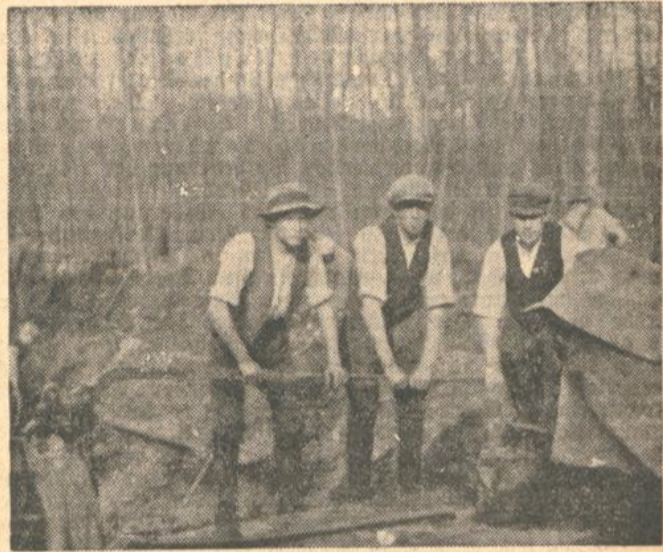
Arbeit an der Pumpe.
