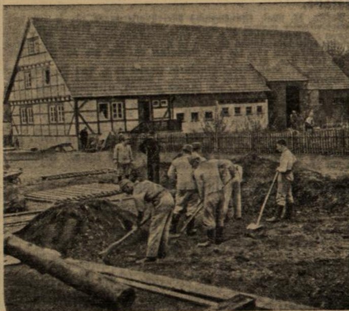
Der Bauernhof auf dem Ausstellungsgelände. (Scherl Bilderdienst, K.)
