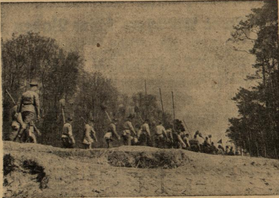
Heimkehr der Arbeitsmänner von der Baustelle.
