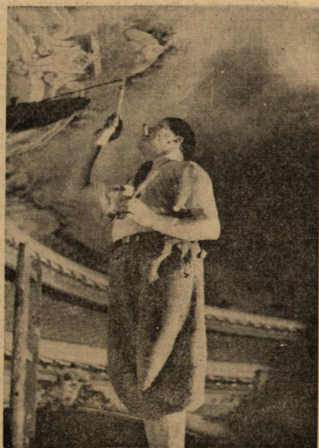
Etwas für Schwindelkreie: Die Decke wird instandgesetzt. Photo: Pagenhardt.
