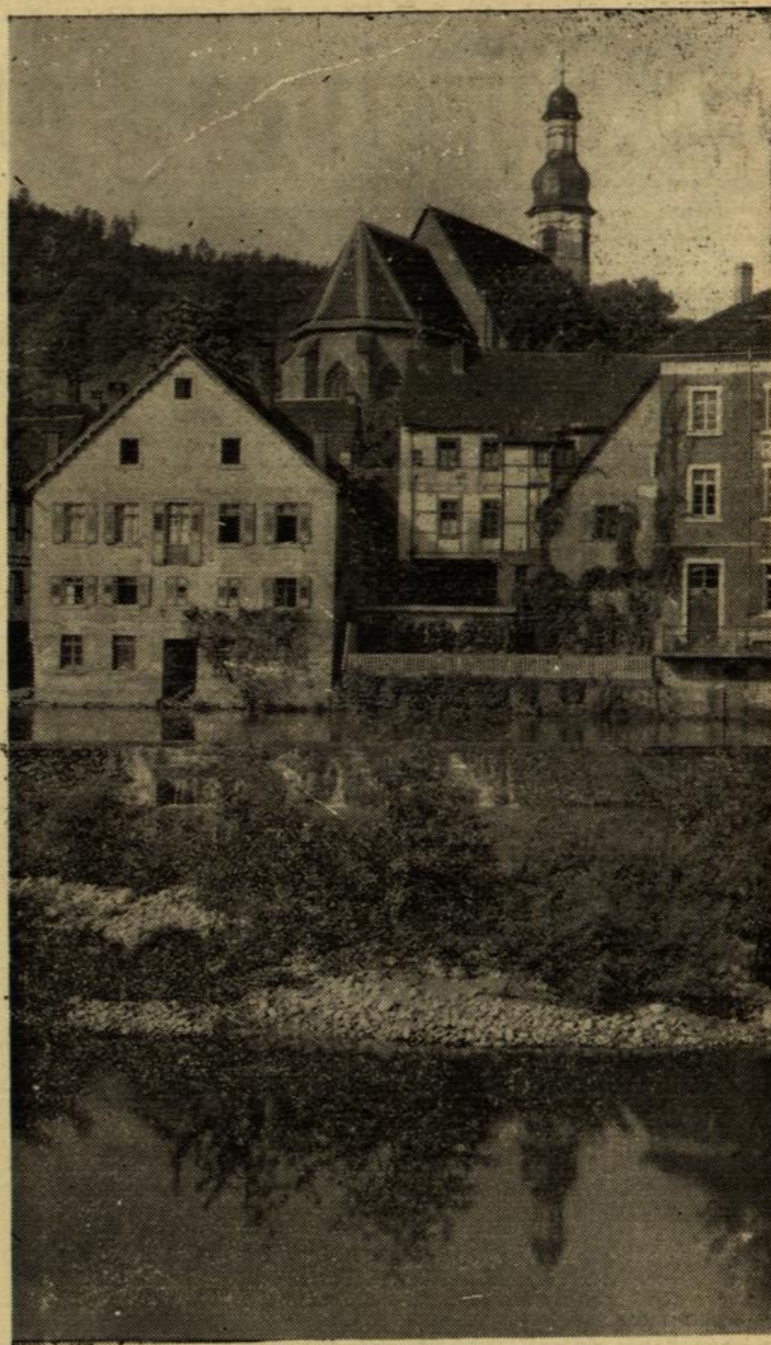
Partie an der Murg (Foto: Reichsbahn)
