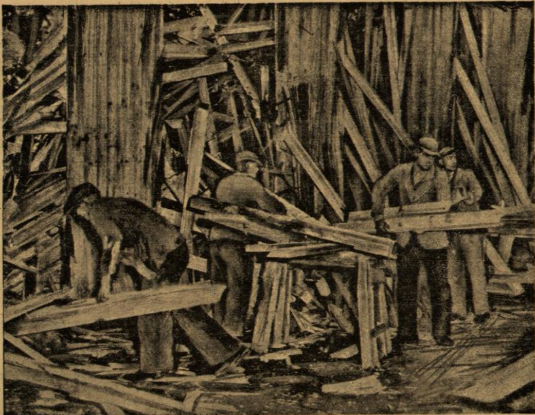
Holztrümmer von den Gerüsten und Verschalungen werden abgeräumt (Reisephot., A.)
