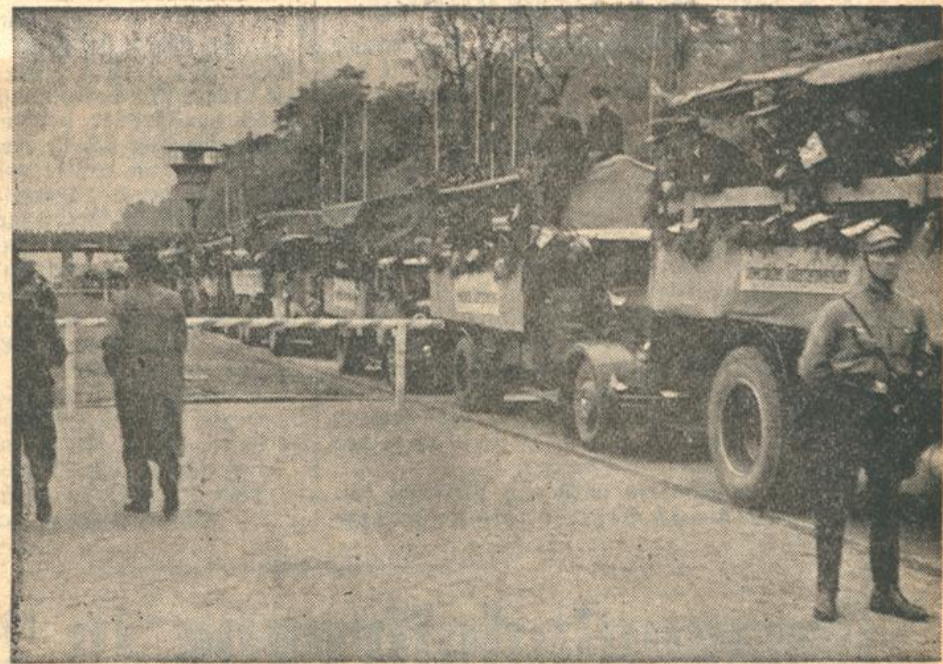
Arbeiter der Autobahn in den Lastwagen, die sie über die Strecke bringen.
