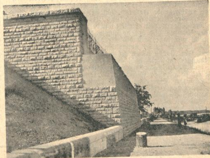
Das fertige Widerlager auf der pfälzischen Seite.
