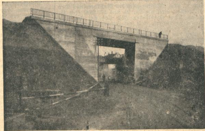
Der Bahndamm der Linie Wörth-Lauterburg.
