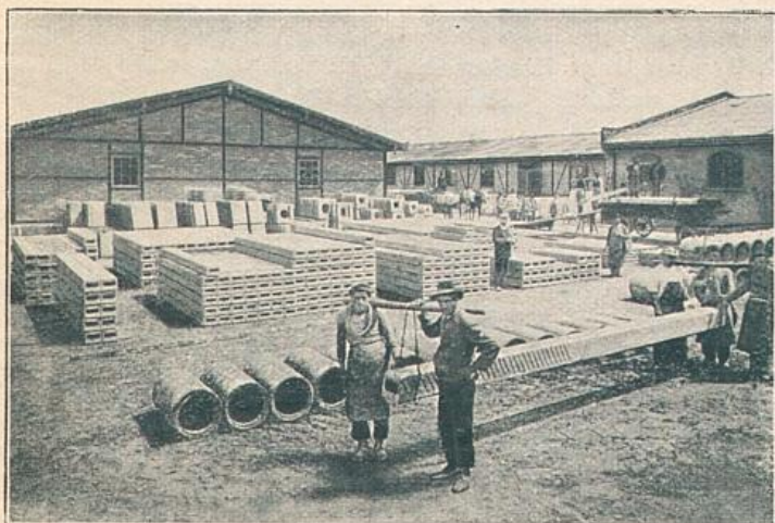
Hohlbalken- lager in der Fabrik Karls- ruhe-Mühl- burg
