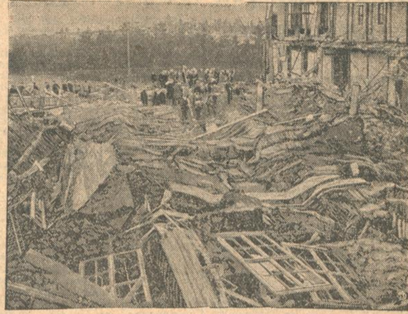
In Kassel-Bettenhausen brannte am Mittwoch plötzlich der vierstöckige Neubau eines Warenhauses ein. Da ein Bauarbeiter kurz vorher bemerkt hatte, daß der Bau schwankte, rief er den Arbeitern zu, den Neubau schnellstmöglich zu verlassen, so daß der größte Teil der Beschäftigten sich retten konnte und nur ein Toter und mehrere Schwerverletzte zu beklagen sind.
