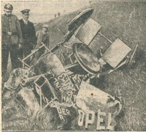
Die Trümmer des Rak 3 nach der zweiten Versuchsfahrt, die mit vierfacher Ladung erfolgte. Sofort nach dem Start explodierte der Wagen unter schwerer Detonation und stürzte auf die Böschung.
