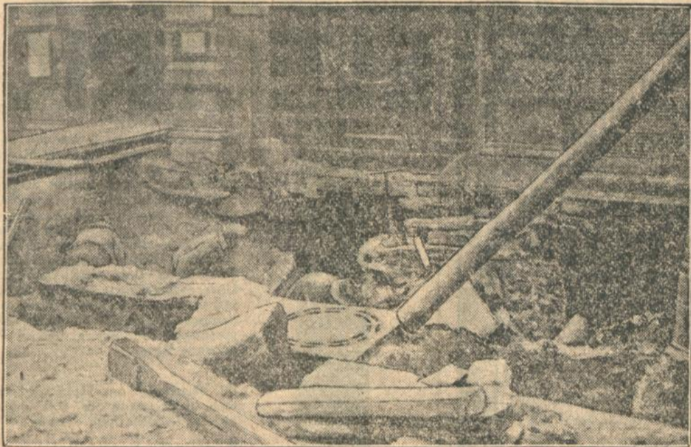
Das durch den Wasserrohrbruch gefährdete Wohnhaus.
