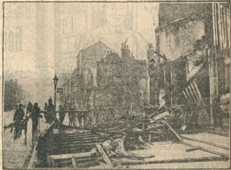
Sturmschäden in der Waterloostraße.
