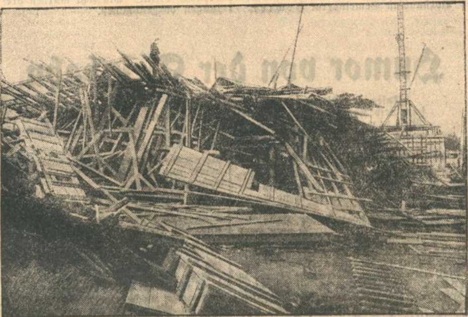
In Dortmund hat ein orkanartiger Sturm schwere Schäden angerichtet. Die im Neubau befindliche Kirche der Petri-Nikolai-Gemeinde, die bereits bis zur Höhe von 30 Metern gediehen war, stürzte wie ein Kartenhaus zusammen.
