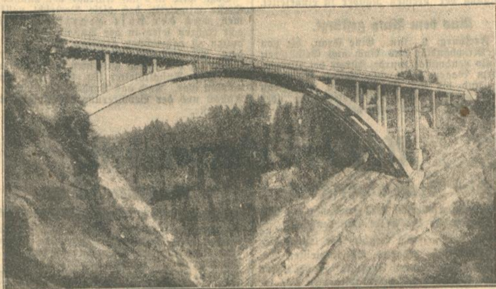
In Bayern wurde kürzlich die Hochbrücke über die Ammer bei Eschelsbach fertiggestellt. Sie ist mit einer Spannweite von 130 m und einer größten Höhe über dem Tal von 72 m die größte Eisenbetonbrücke Deutschlands. Die Gesamtlänge der nur für Straßenverkehr bestimmten Brücke beträgt 182 m, die Breite der Fahrbahn 6 m.
