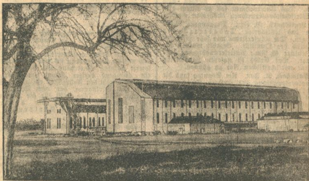
Die neue gigantische Halle auf dem Werftgelände der Luftschiffbau-Zeppelin G. m. b. H. in Friedrichshafen ist jetzt ihrer Bestimmung übergeben worden. Sie mißt 245 m Länge, 50 m Breite und ist 46 m hoch.
