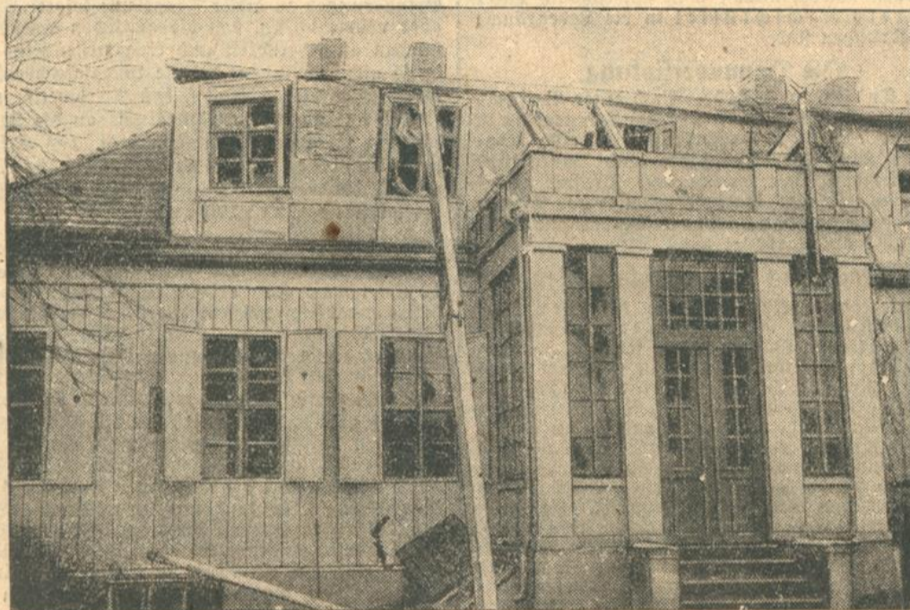
Das schwer beschädigte Wohnhaus in Berlin-Buchholz.
