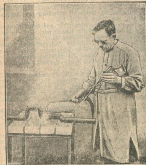
Der Kombinationsbrenner beim Schneiden.
