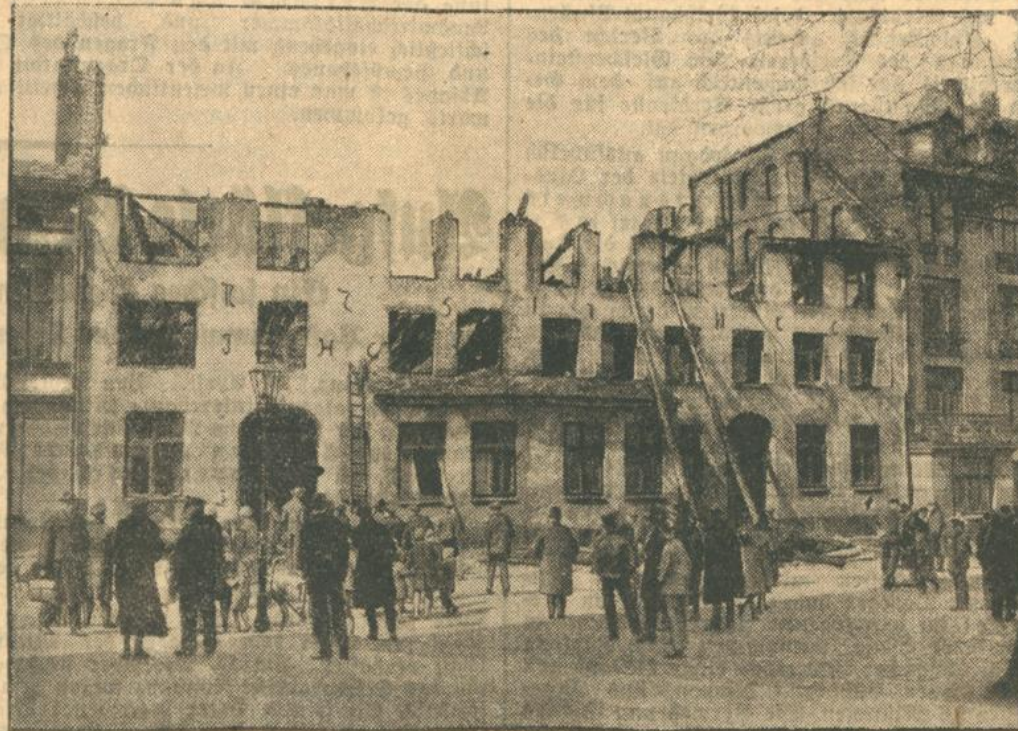
Das völlig ausgebrannte Speicherhaus.
