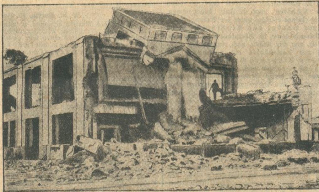
Das gesprengte Verwaltungsgebäude zum Flugplatz Lachen bei Neustadt a. d. H.
