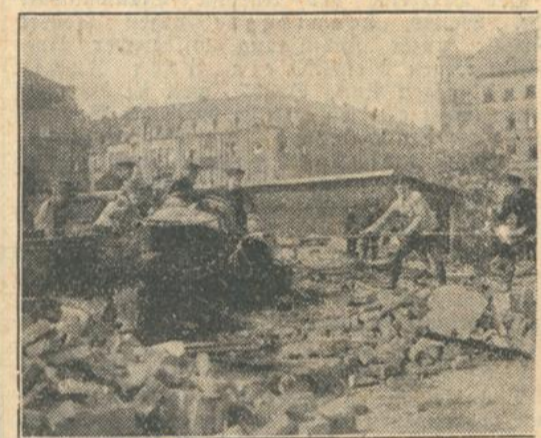
Die Trümmer der Unglücksstätte.
