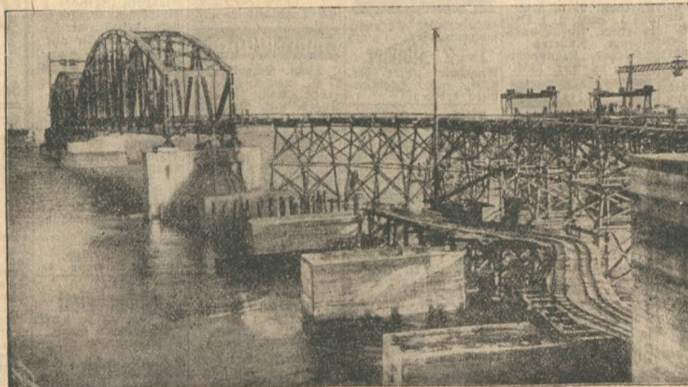
Beginn der Eisenmontage der neuen Pantschewobrücke.
