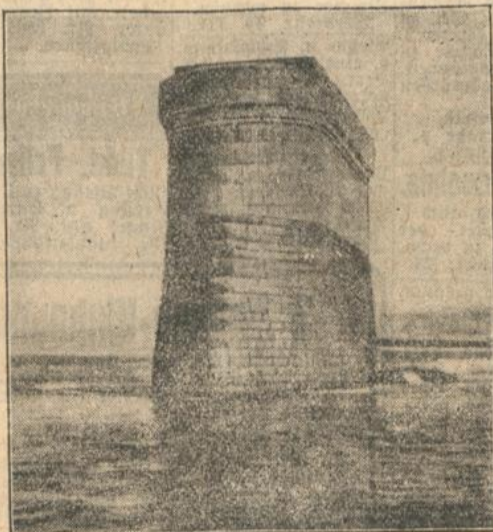
Einer der fertigen Strompfeiler.
