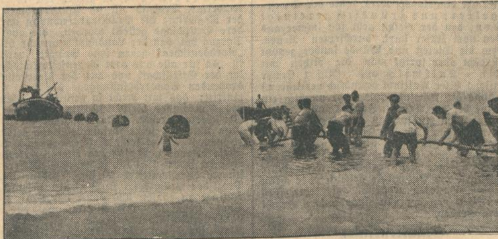
Die Verlegung des Kabels an der Küste bei Warnemünde.
