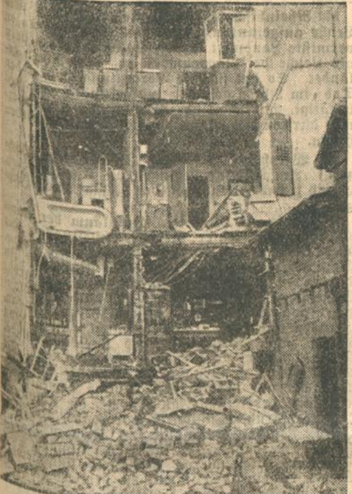
Lastwagen verursacht Hauseinsturz. In Darmstadt ereignete sich ein schwerer Verkehrsunfall, bei dem acht Personen verletzt wurden. Das Unglück ereignete sich durch das Vordringen zweier Lastwagen, die die Eisenbahnrampe zu erschütterten, daß die Vorderwand einstürzte.
