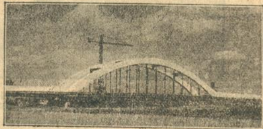
Landstraßenbrücke über dem neugeschaffenen Bett der Kinzig.
