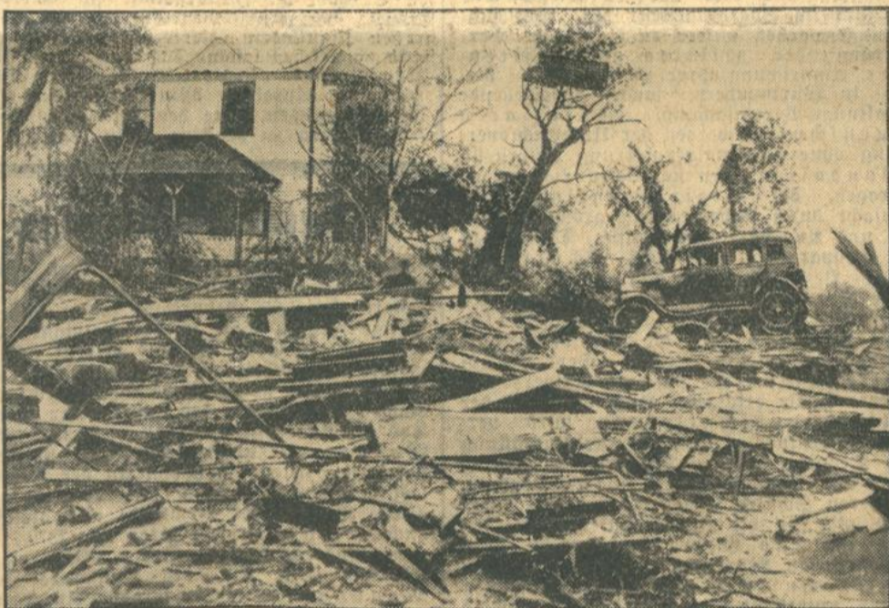
Wirbelsturmverwüstungen in Eureka (U. S. A.).
