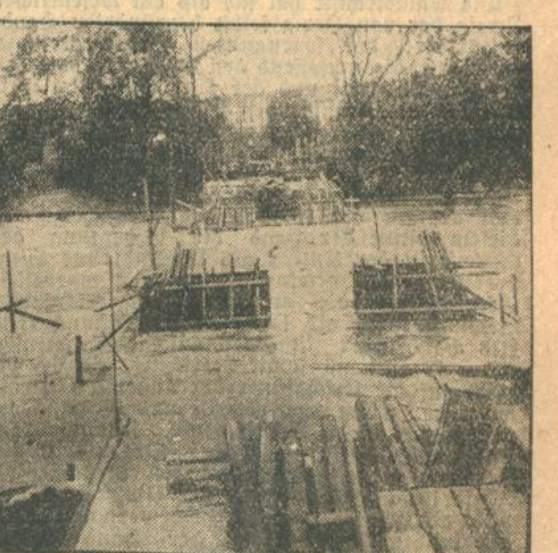
Eine von den Fluten zerstörte Brücke in Neiße.
