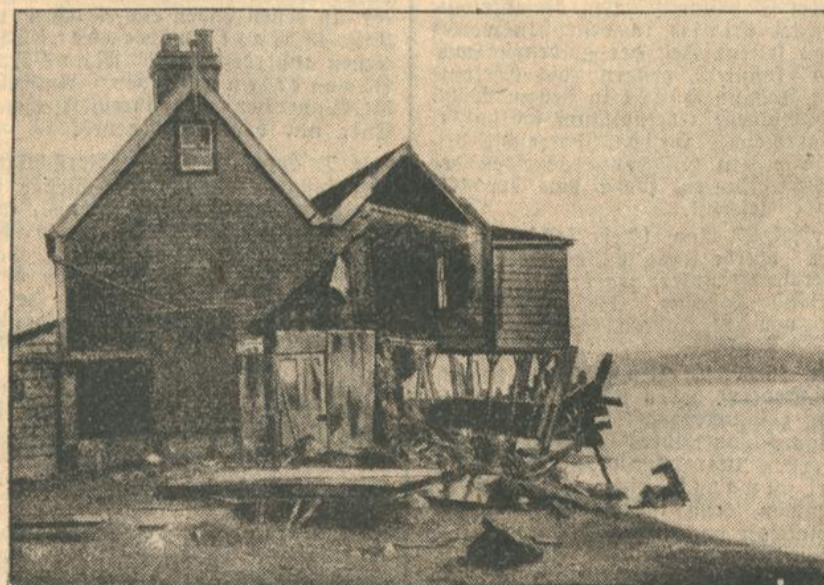
Eingestürztes Haus bei Winchelsea (Südengland).
