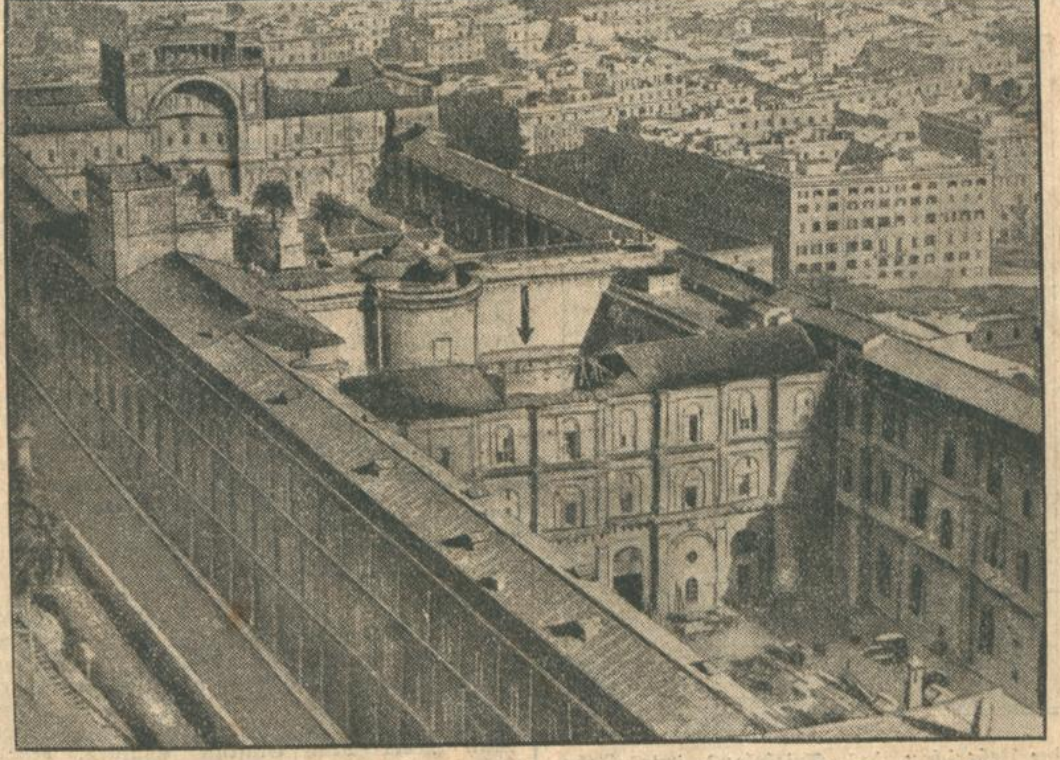
Blick auf den Gebäudekomplex der Bibliothek (der Pfeil bezeichnet die Einsturzstelle). Anwohner haben die Aufräumarbeiten im Vatikan an der Einsturzstelle der Bibliothek zunächst eingestellt werden müssen. Um einen vorläufigen Schutz gegen die Risse zu schaffen, die die Bergung der noch unter den Trümmern befindlichen Bücherkisten gefährden kann, sind die Schutzmassen mit einer Lage Dachpappe abgedeckt worden.
