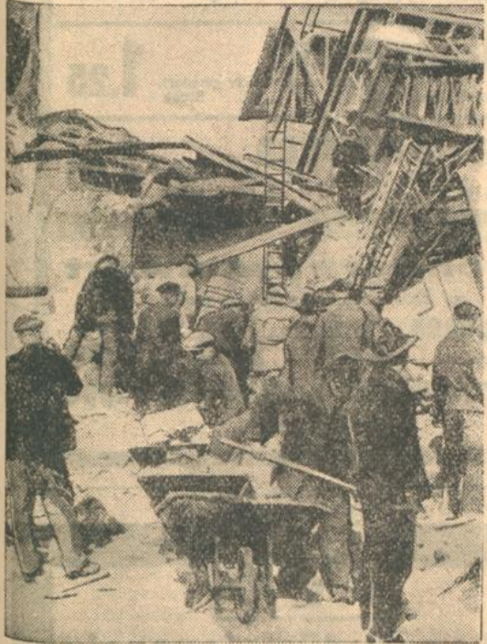
Aufräumungsarbeiten über Tage.
