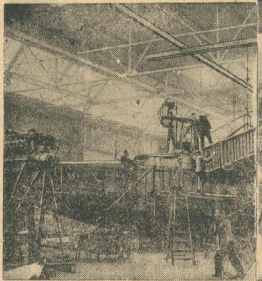
Einbau der Motoren in das Romarflugboot.
