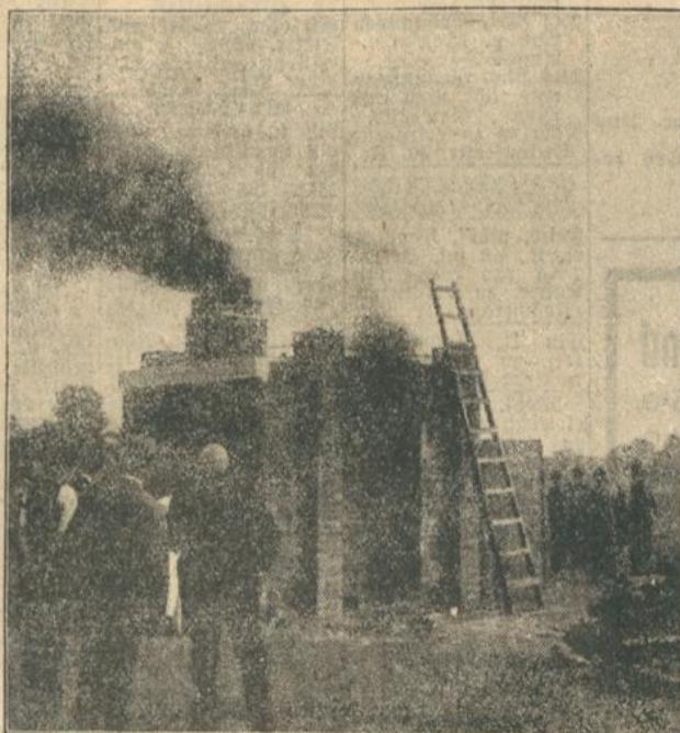
Prüfung der Feuerbeständigkeit des neuen Holzbau-Systems durch das Staatliche Material-Prüfungsamte.
