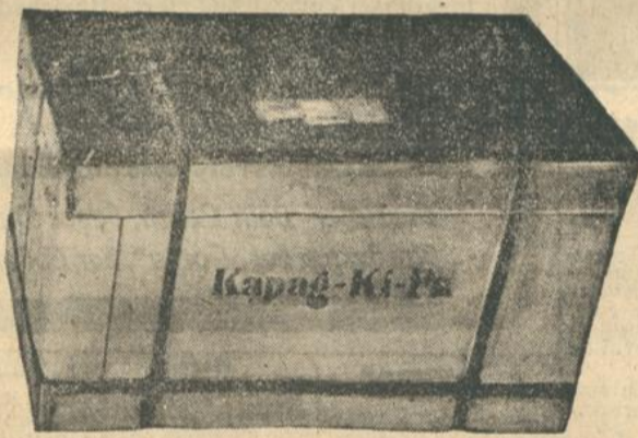
Diese Pappkiste wurde, mit Büchern beladen, 1500 km weit mit der Eisenbahn verschickt.
