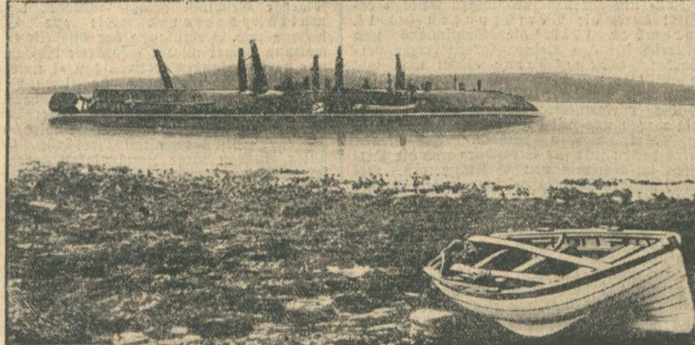
Kreuzer „Von der Tann“ nach der Hebung. In der Bucht von Scapa Flow wurde der versenkte deutsche Kreuzer „Von der Tann“ unter großen Schwierigkeiten gehoben und zur Verschrottung abgehievt.
