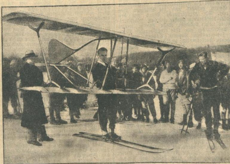
Mit diesem Apparat, nach dem Prinzip des Segelflugzeugs konstruiert, vermag der Skifahrer nach kurzem Anlauf in großer Schnelligkeit über die Säue hinwegzugleiten. Der neuartige Apparat erregte bei seiner ersten Vorführung bei New York großes Aufsehen.
