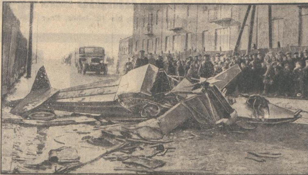
Die zertrümmerte Maschine auf dem Straßenpflaster.
