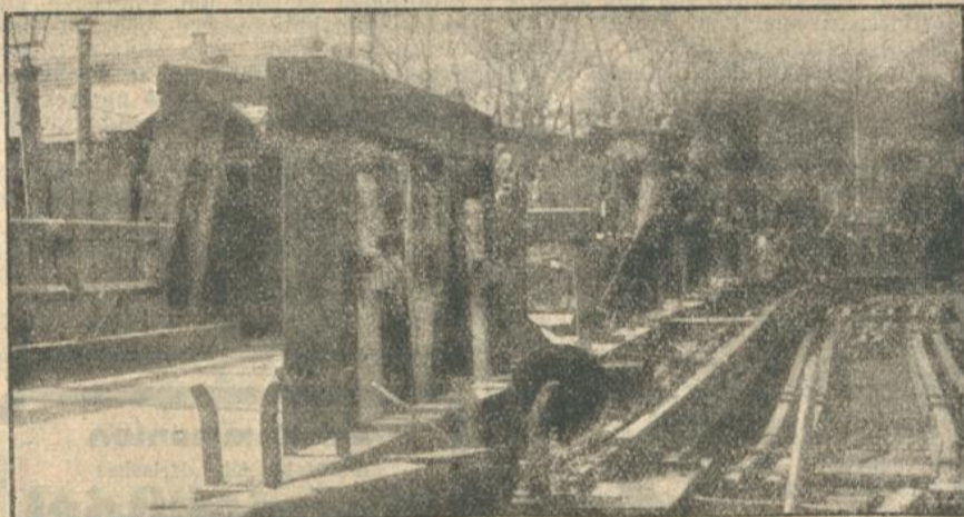
Blick auf die schwer beschädigte Brückenstelle. Photo: Bauer, Karlsruhe.
